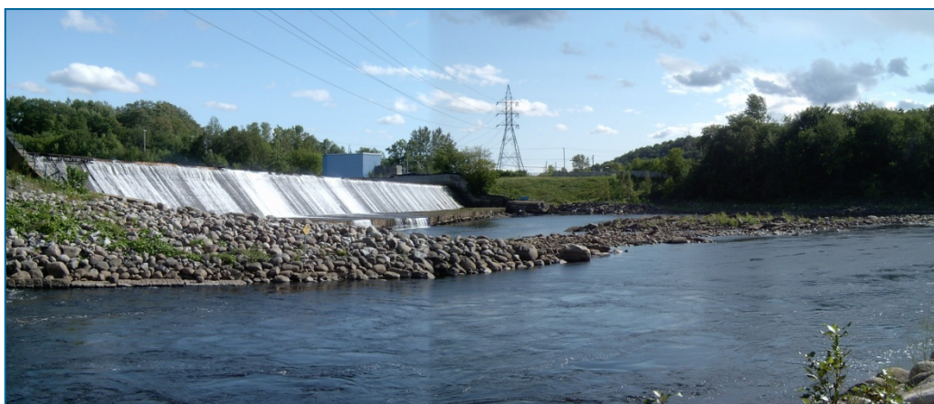
Barrage hydroélectrique Crédit photo : MRC de Portneuf
